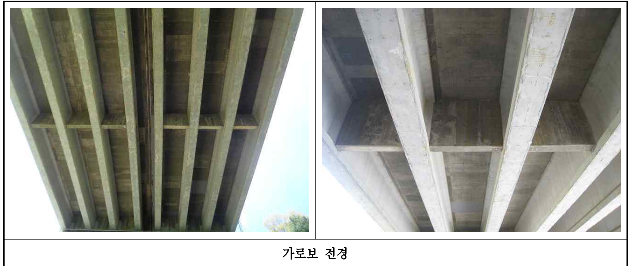
【사진 1.3.6】 가로보 전경
