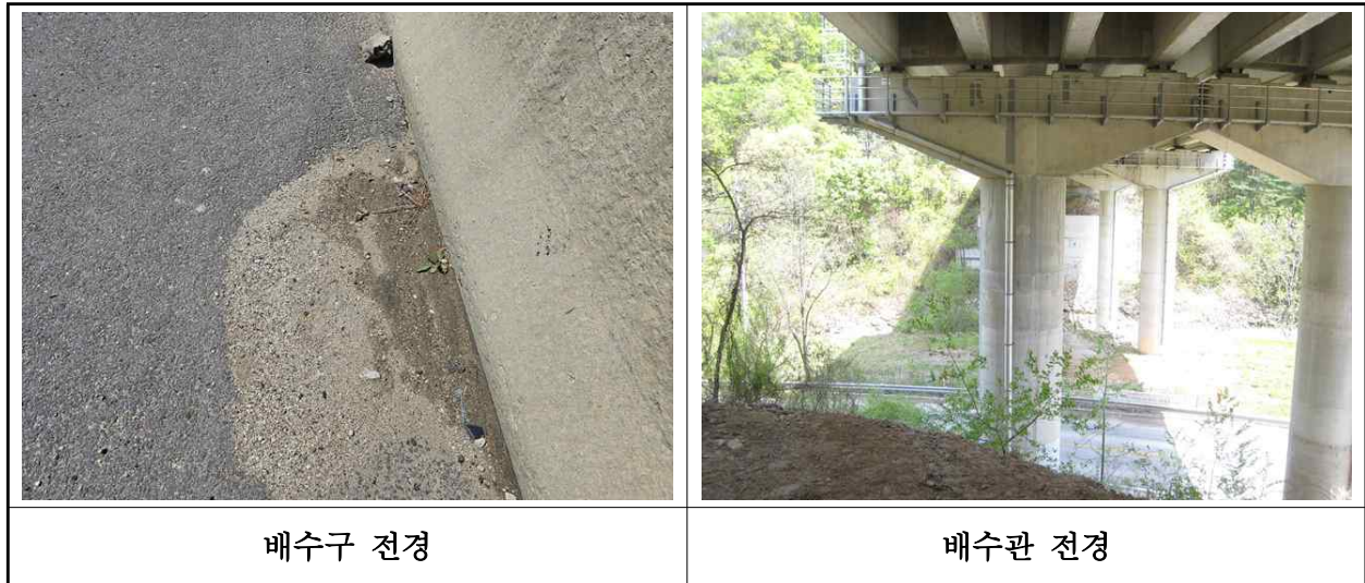
【사진 1.3.21】 배수시설 전경
