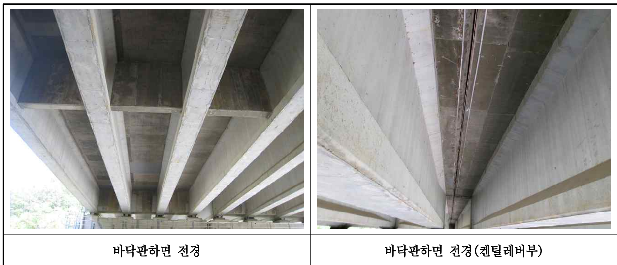
【사진 1.3.2】 바닥판하면 전경
