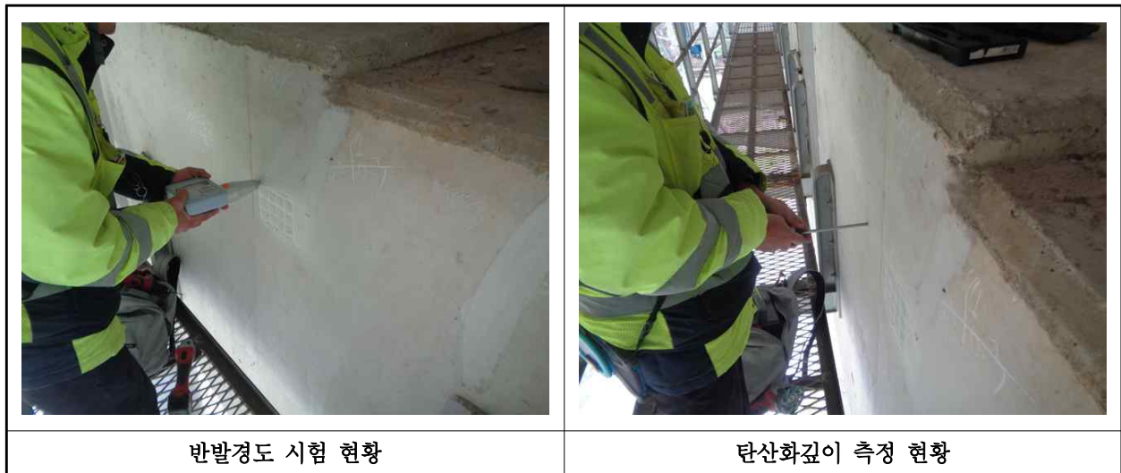
【사진 1.4.1】 콘크리트 내구성조사 현황
