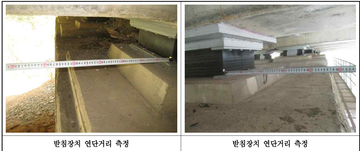
【사진 1.3.14】 교량받침장치 연단거리측정
