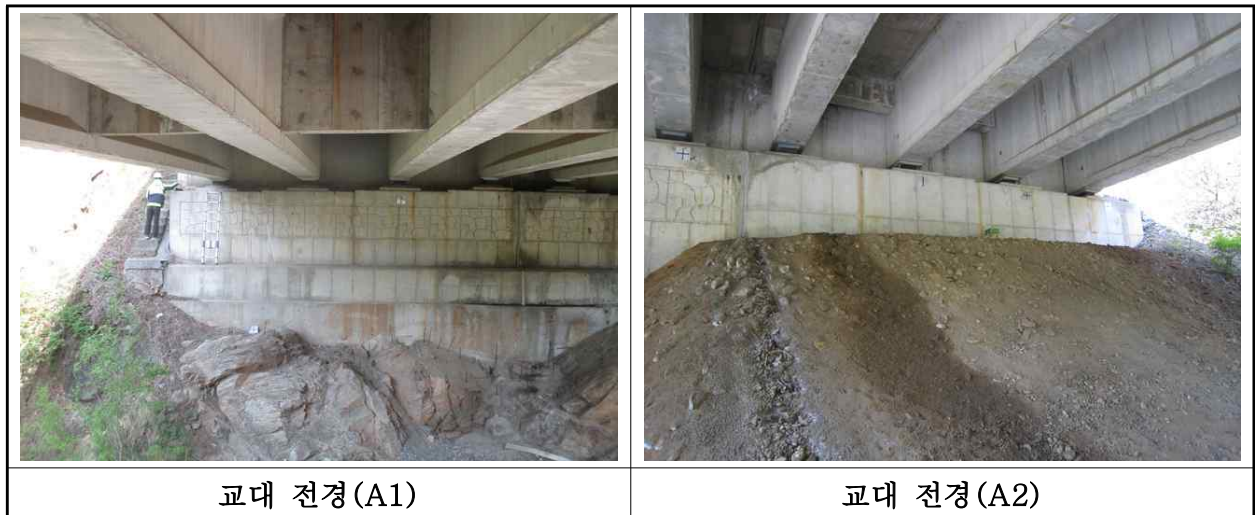
【사진 1.3.8】 교대 전경
