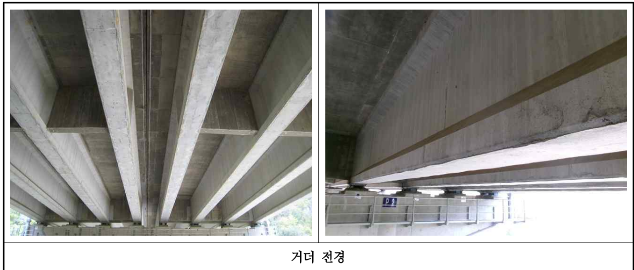
【사진 1.3.4】 거더 전경
