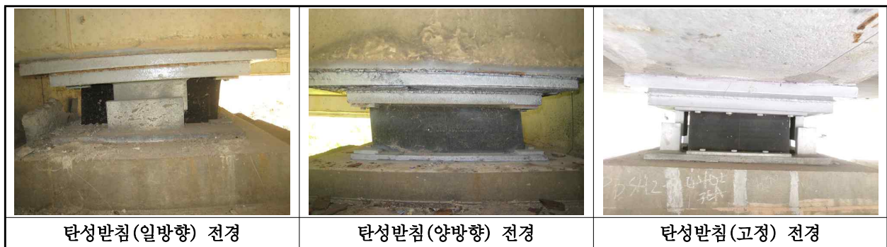
【사진 1.3.12】 교량받침 전경
